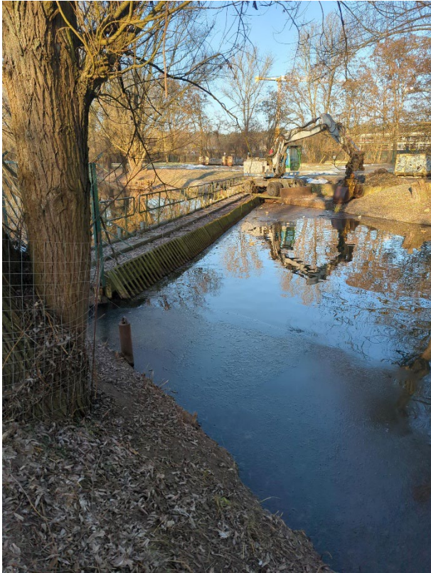
Abbildung 3: Rechenbauwerk kurz vor der Hämmerlingbrücke
