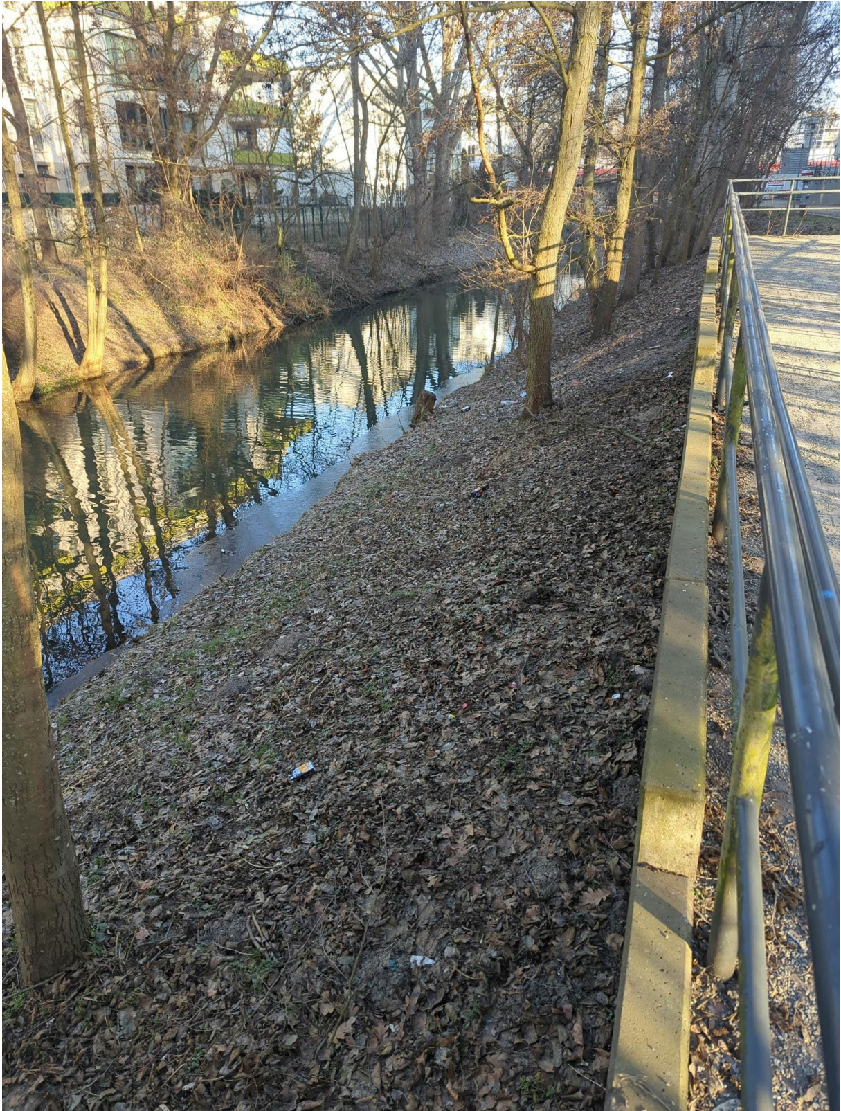
Abbildung 2: Begradigte Wuhle mit steilen Böschungen und defizitärer Gehölzstruktur
