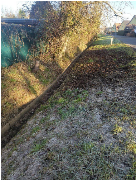
Abbildung 2: Begradigter Verlauf mit U-Profil eingeengt entlang der Tolkmittstraße
