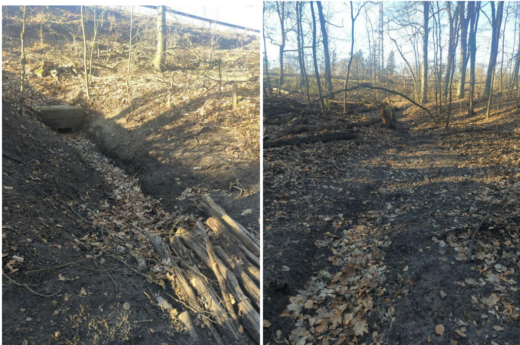
Abbildung 2: Trockene Rinne des Tatarengrabens ausgehend vom Bahngelände (südlicher Verlauf)
