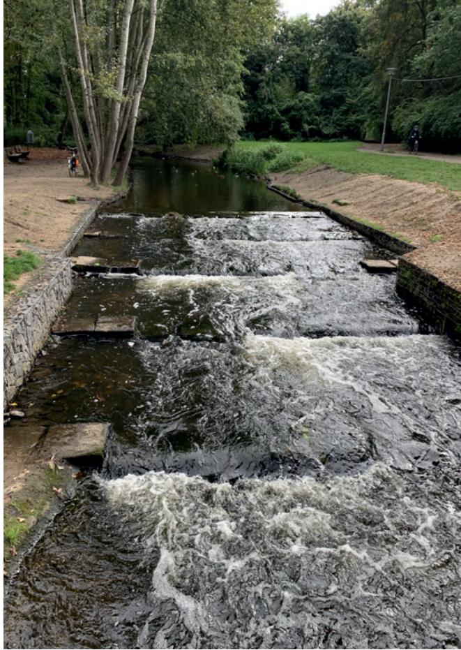
Im Jahr 2015 erbaute Fischtrappe an der Panke, Höhe Schlosspark Niederschönhausen.
