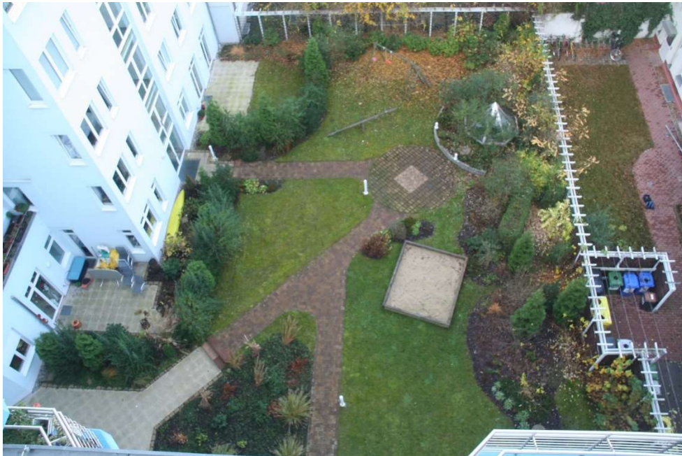
Begrünung einer Tiefgarage in Berlin-Steglitz, Foto: Reinhardt Löw
