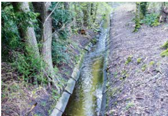
Um das Wasser des Packereigrabens schnell abzuleiten, wurde der Graben mit Steinplatten versiegelt. Das unverbauter Umfeld zeigt: Hier ist mehr für die Natur möglich.
