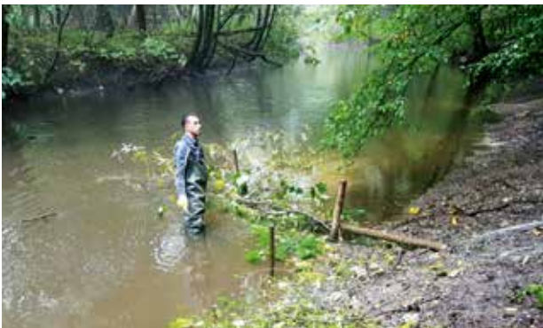
Das Gehölz ist in das Gewässer eingebracht und gesichert.
