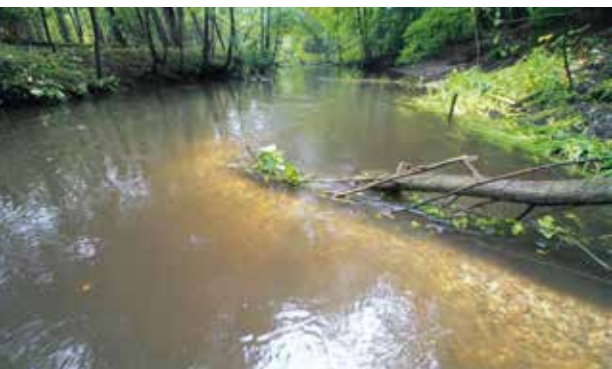
Das Ergebnis lässt sich sehen: ein Strömungslenker aus Kies mit Totholz. Weitere Informationen zu dem Projekt unter: lebendigealster.de
