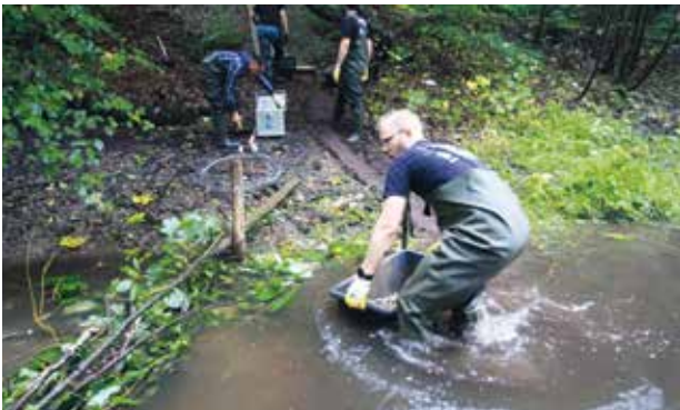
Kies wird in das Gewässer eingebracht.
